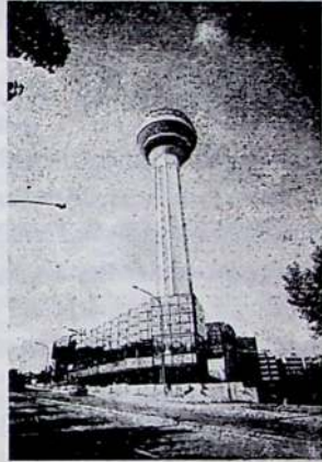
Atakule Isıtma Havalandırma Klima ve Sıhhi tesisatları
