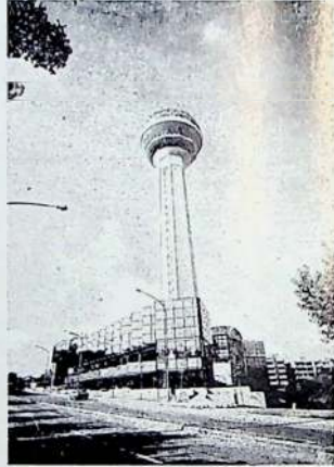
Atakule Isıtma Havalandırma Klİma ve SPM tesisleri
