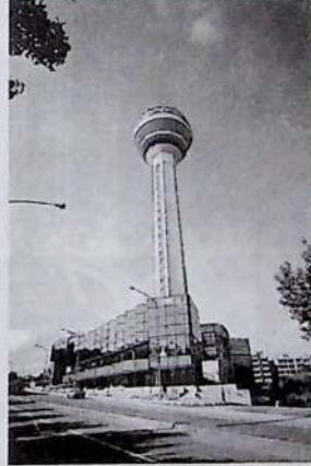
Alaküle Isıtma Havalandırma Klİma ve Sıhhi tesisatın
