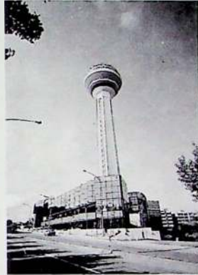
Azıkule Isıtma Havalandırma Klİma ve Sıhhi tesisatları
